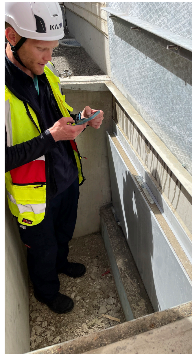
Kontroll av rökluckor.
