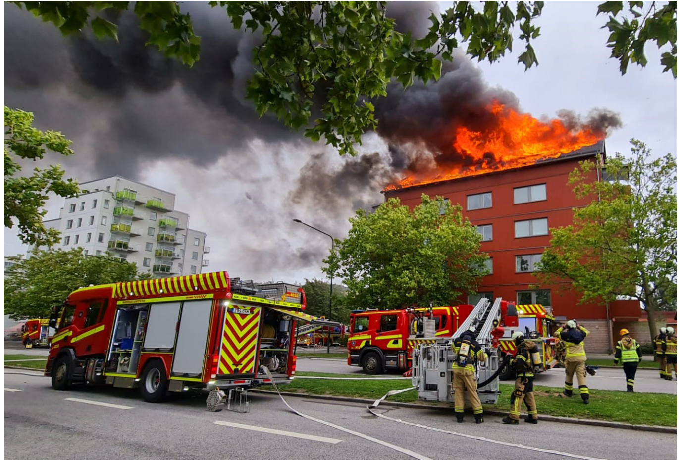
Branden på Munkhätttegatan 2023 i Malmö. Branden startade i ett lägenhetsförråd på vinden och spreds mellan brandcellsgränserna. Det ledde till stora konsekvenser för de boende och Räddningstjänsten Syd hade resurser på plats i två dygn.
