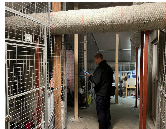
Tillsyn i ett vindsutrymme.
